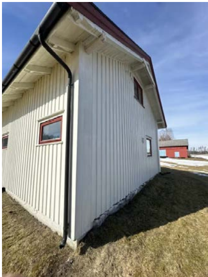
Drensrør anbefales montert på alle nedløp slik at overflatevann blir ført bort fra grunnmur.
