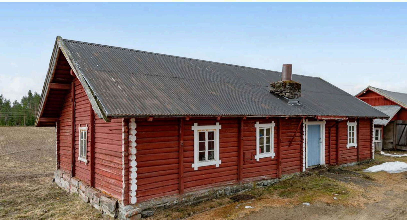
Fjøset består av gang og to fjøsrom - der rommet mot sør-øst er overflatebehandlet og innredet med benk og bord.
