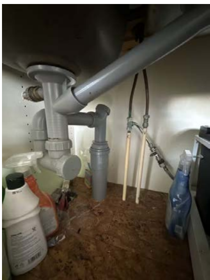
Viser vann og avløpsinstallasjoner under kum.
