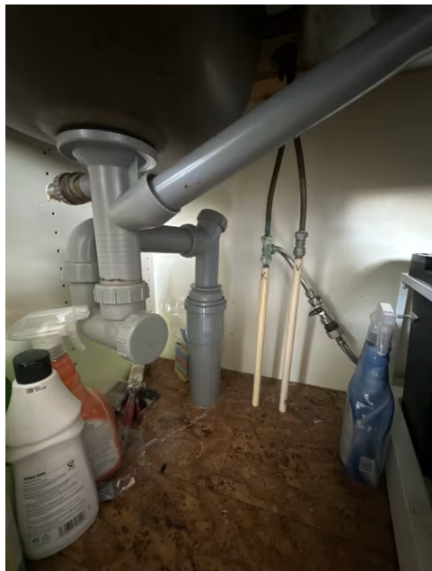
Viser vann og avløpsinstallasjoner under kum.
