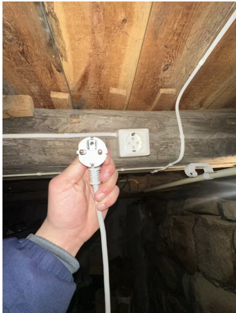
Ingen tegn til varmgang ved støpsel.
