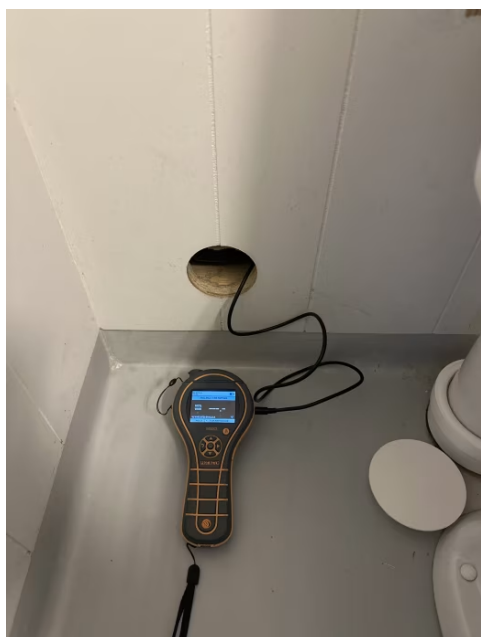
Hulltaking foretatt på toalettrom mot dusjsone.
