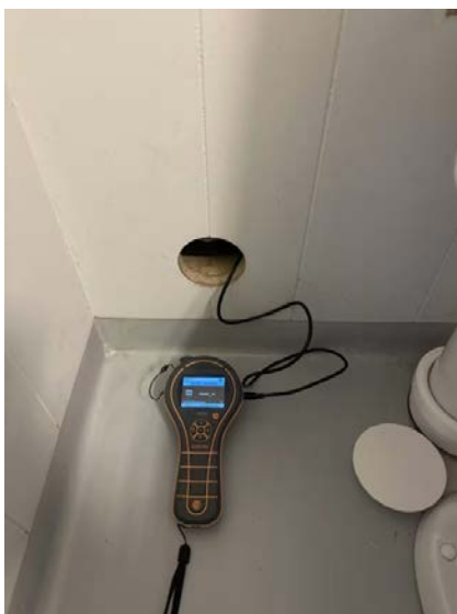
Hulltaking foretatt på toalettrom mot dusjsone.
