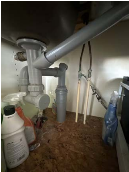
Viser vann og avløpsinstallasjoner under kum.
