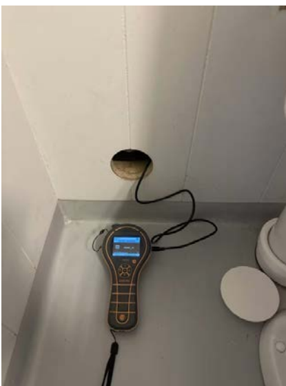
Hulltaking foretatt på toalettrom mot dusjsone.
