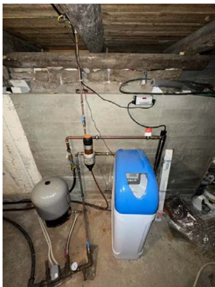
Viser stoppekran, trykktank og renseanlegg i teknisk. Funksjon og tilstand må vurderes av fagmann.
