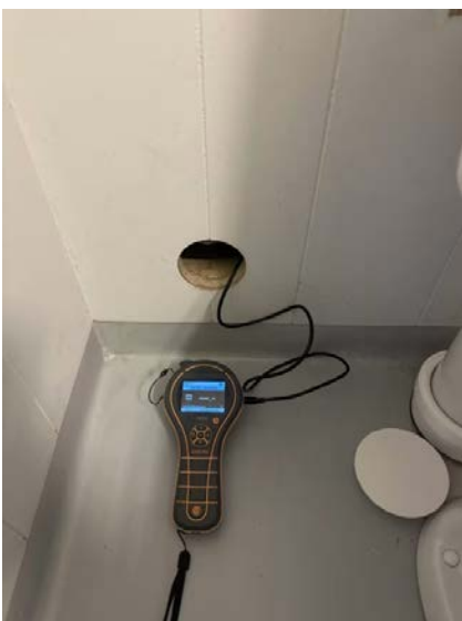
Hulltaking foretatt på toalettrom mot dusjsone.
