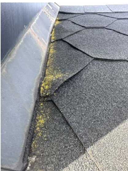
Viser sprekker i tekkingen, lokale utbedringer må påregnes.
