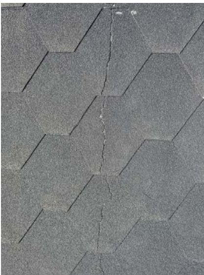
Viser sprekker i tekkingen, lokale utbedringer må påregnes.
