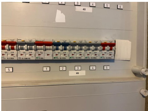
Automatsikringer med skap i fellesgang.
