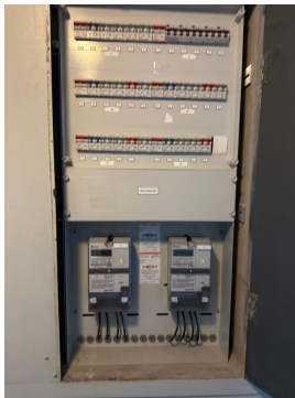
Automatsikringer med skap i fellesgang.
