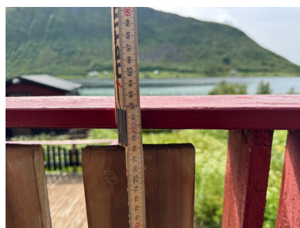
Rekkverkshøyden.
