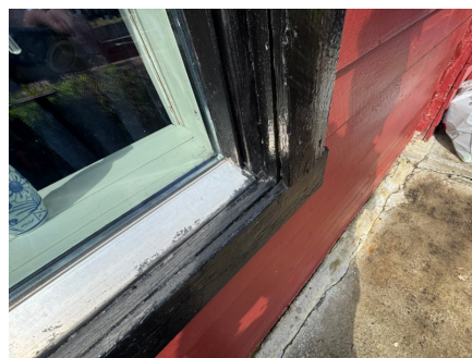
Det er ikke montert beslag under enkelte vinduer.
