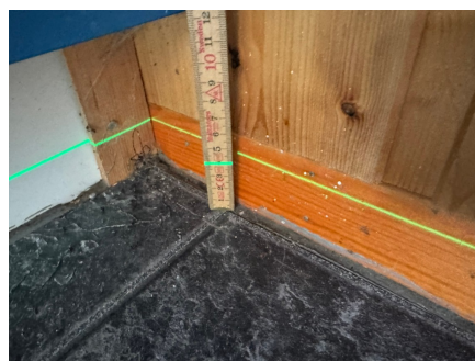
Måling av etasjeskillet på kjøkkenet.
