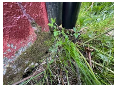
Nedløp er avsluttet over terrenget.
