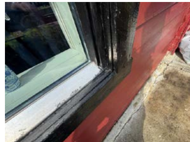
Det er ikke montert beslag under enkelte vinduer.
