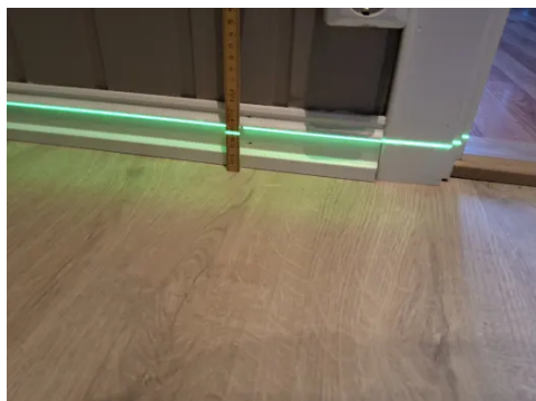
Etasjeskillet er kontrollert med nivelleringslaser.
