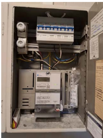
Sikringsskap er plassert i felles trappeoppgang.
