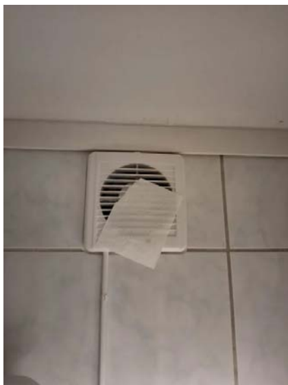
Avtrekkseffekten er testet med papir.
