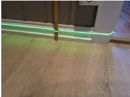
Etasjeskillet er kontrollert med nivelleringslaser.
