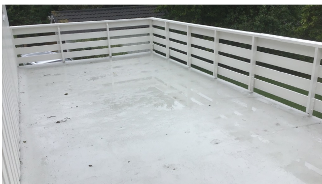
terrasse over garasje
