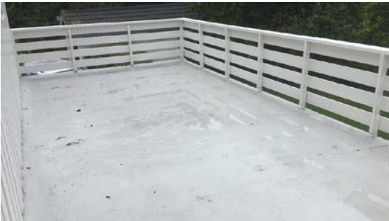
terrasse over garasje
