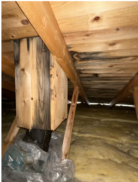
Det er påvist fuktskjolder i undertak/takkonstruksjon ved gjennomføring til ventilator på kjøkkenet.
