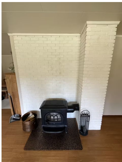
Viser ildsted montert i stue 1.etasje
