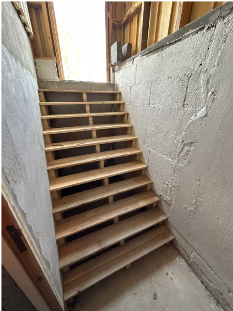
Viser trapp med utvendig adkomst til kjeller.
