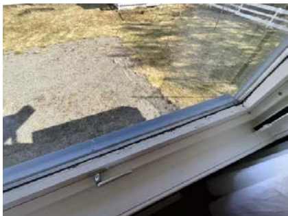
Det registreres misfarging på innvendige karmner og foringer, trolig pga. kondens.
