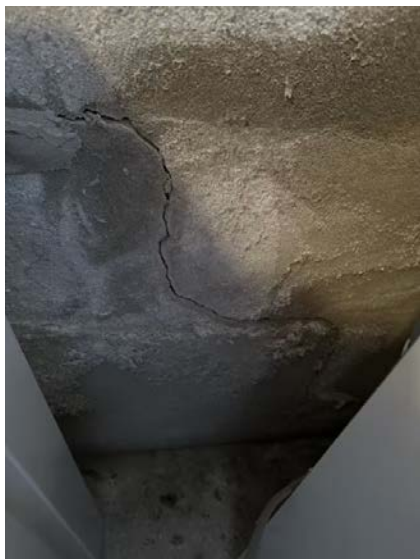
Det registreres mineralutslag (salt/kalkutsalg) i overflater som er et symptom på fuktvandring gjennom grunnmur.
