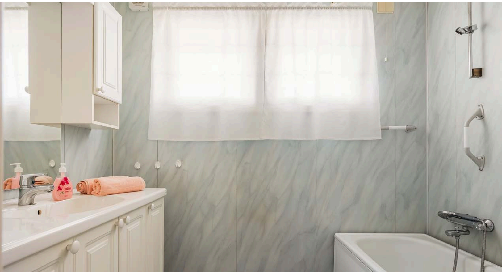
Eldre badrom som må totalrenoveres. Baderommet har belegg på gulv, baderomsplater på veggene, elektrisk stråleovn og mekanisk vifte. Rommet er utstyrt med innredning med servant, speil med belysning og vegghengte skap, samt badekar.
