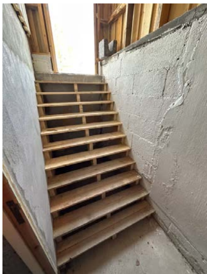
Viser trapp med utvendig adkomst til kjeller.
