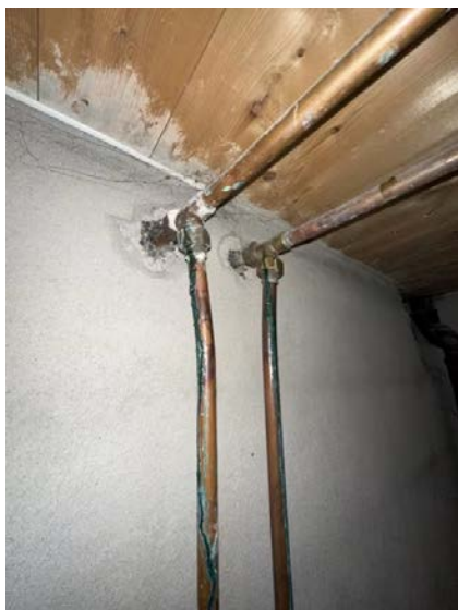
Viser irr på rør og koblinger.
