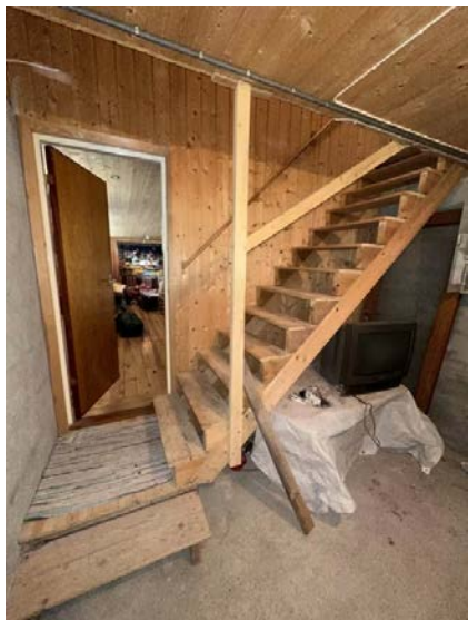
Viser trapp mellom etasjer.
