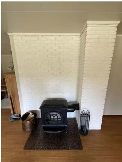
Viser ildsted montert i stue 1.etasje
