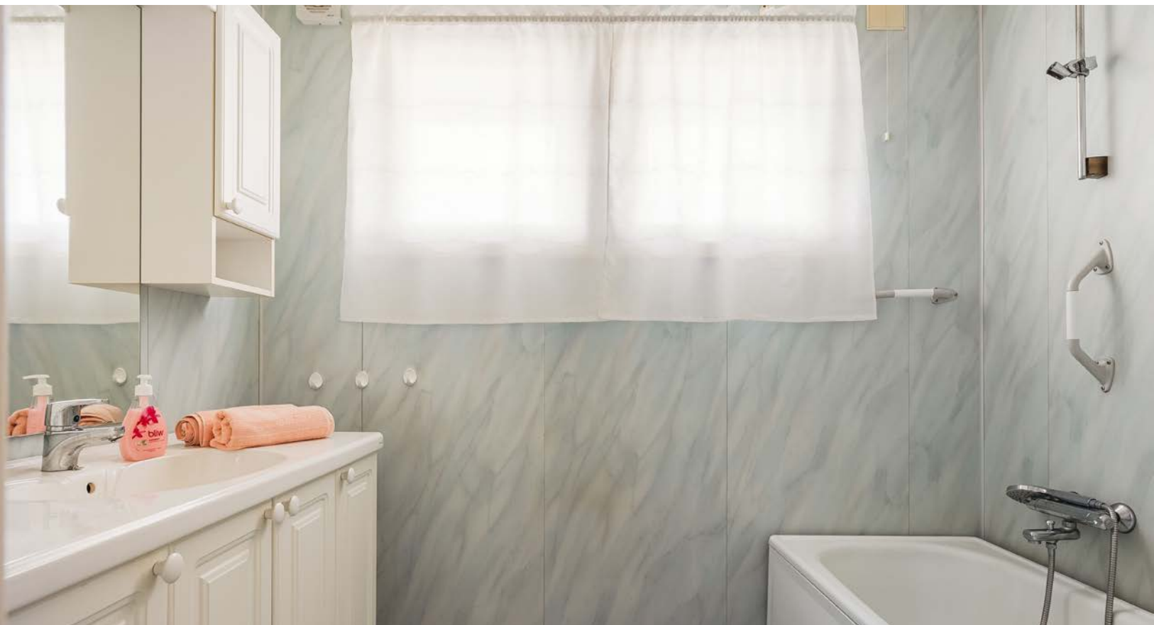
Eldre baderom som må totalrenoveres. Baderommet har belegg på gulv, baderomsplater på veggene, elektrisk stråleovn og mekanisk vifte. Rommet er utstyrt med innredning med servant, speil med belysning og vegghengte skap, samt badekar.
