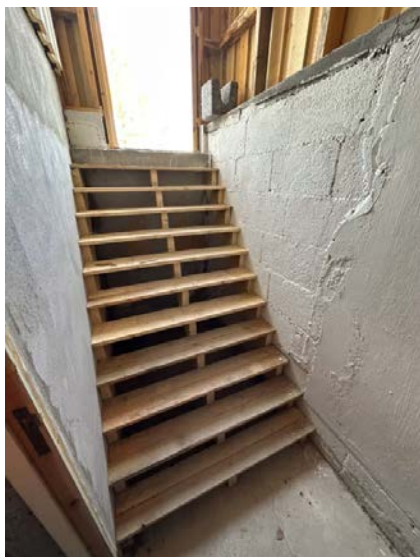
Viser trapp med utvendig adkomst til kjeller.
