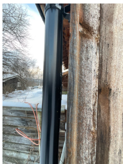
Takvann er ikke ledet bort fra grunnmur
