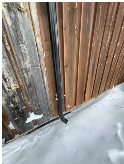
Takvann er ikke ledet bort fra grunnmur
