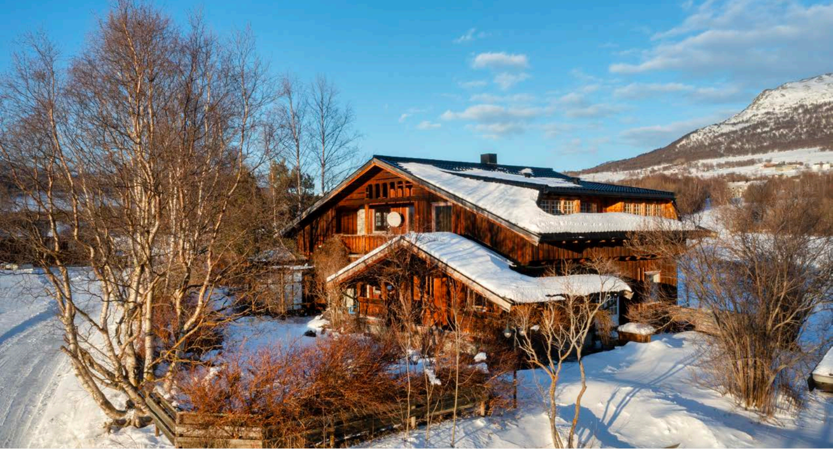
Fasade ( Foto: Ludvig Killingberg/ Killingberg Foto og Rammeverksted)
