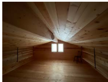
Takkonstruksjon i tilbygg.
