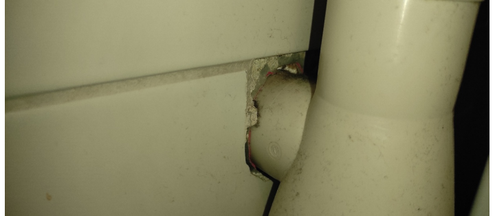
Kontroll av membran rundt rørgjennomføringen.
