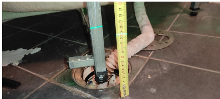
Kontroll av fall mot sluk.
