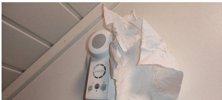
Funksjonstest av avtrekk.
