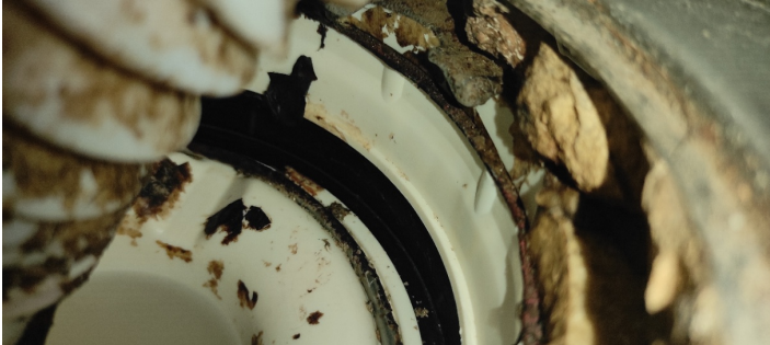
Kontroll av membran rundt sluk.
