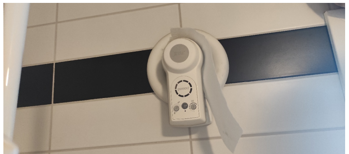
Funksjonstest av avtrekk.
