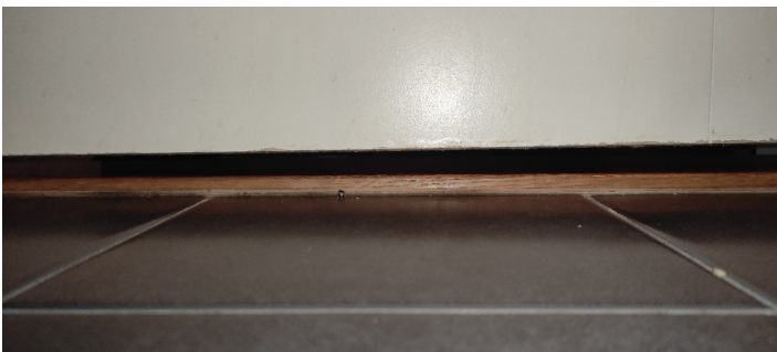
Kontroll av høyde på luftespalte under døren.
