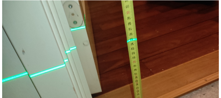
Kontroll av fall mot sluk.
