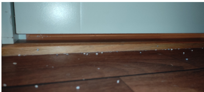
Kontroll av høyde på luftespalte under døren.
