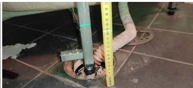
Kontroll av fall mot sluk.
