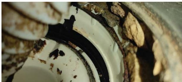
Kontroll av membran rundt sluk.
