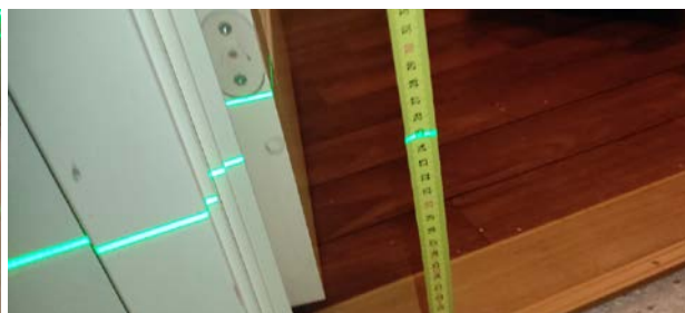
Kontroll av fall mot sluk.
