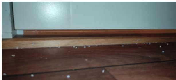
Kontroll av høyde på luftespalte under døren.
