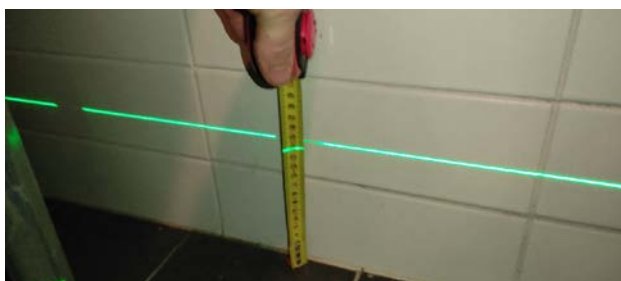
Kontroll av fall mot sluk.
