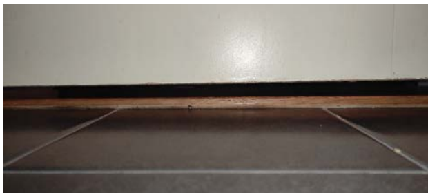
Kontroll av høyde på luftespalte under døren.
