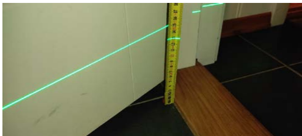
Kontroll av fall mot sluk.
