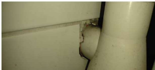
Kontroll av membran rundt rørgjennomføringen.
