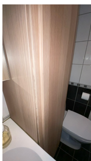
Liten skade/folieslipp på høyskap
