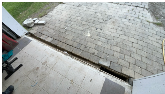
Renne på utsiden av garasjeport i terreng er skadet som følge av press fra belegningsstein
