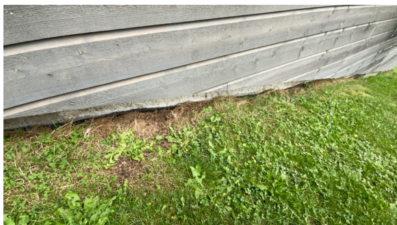
Mangler kantlist på grunnmursplast
