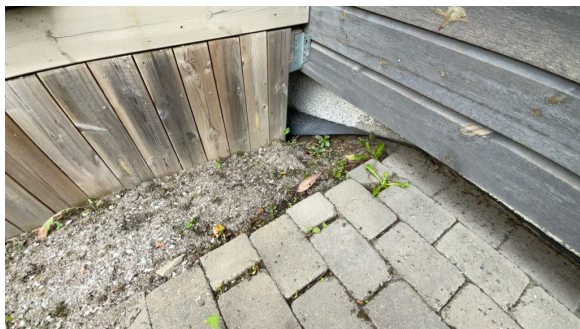
Mangler kantlist på grunnmursplast
