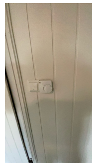
Varme styres av romtermostater på de ulike rommene
