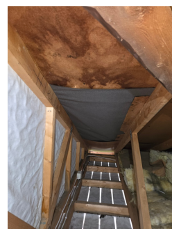
Undertak er utbedret av selger over stue mot veranda
