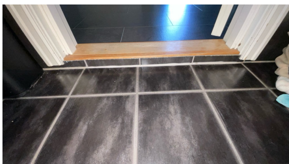
Ved kontroll av høyde på membran er det hensyntatt at membran er ført opp under dørterskel. Oversikt
