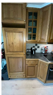
Mangler rist/deksel over dør hvor det tidligere har vært integrert kjøleskap. Oversikt
