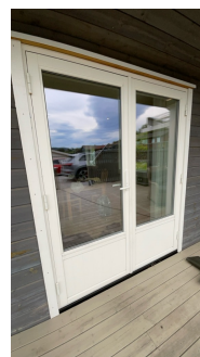
Dobbel balkongdør med utgang fra stue/kjøkken fra 2014
