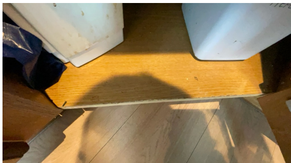
Noe slitasje på kant inne i kjøkkenskap
