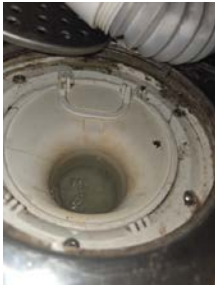
Mansjett er ført ned under skrudd klemring på plastsluken.
