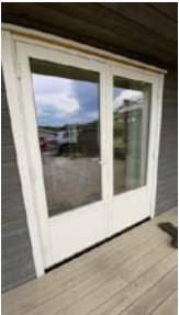
Dobbel balkongdør med utgang fra stue/kjøkken fra 2014
