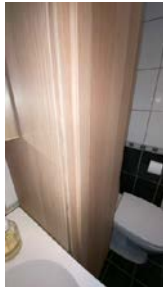
Liten skade/folieslipp på høyskap
