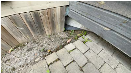
Mangler kantlist på grunnmursplast
