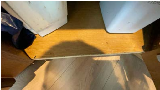
Noe slitasje på kant inne i kjøkkenskap
