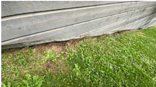
Mangler kantlist på grunnmursplast
