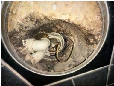
Sluk i plast, plassert i dusjnisje
