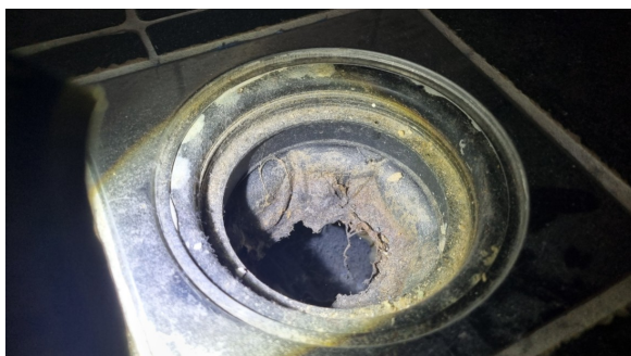
Kontroll av sluk.
