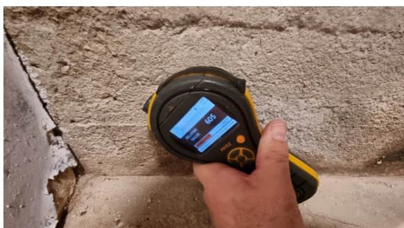
Fuktmåling i kjeller.
