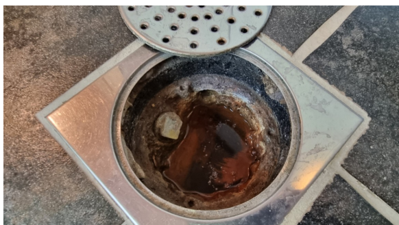
Kontroll av sluk.
