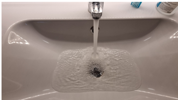
Kontroll av vanntrykk og avrenning.
