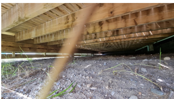
Kontroll av fundamenteringen under terrassen.
