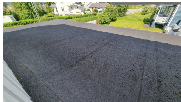
Visuell besiktelse av taket.
