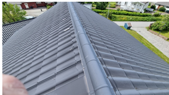
Visuell besiktelse av taket.
