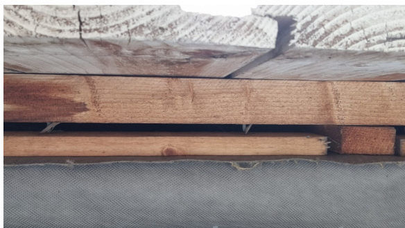
Kontroll av ytterkledningen.
