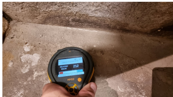
Fuktmåling i kjeller.
