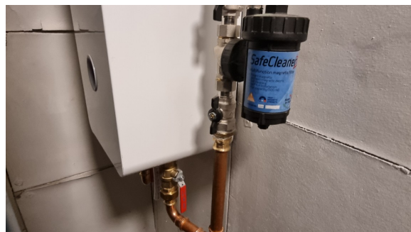
El-kassett for gulvvarmen er plassert i fyrrommet.
