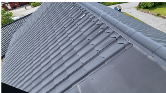
Visuell besiktelse av taket.
