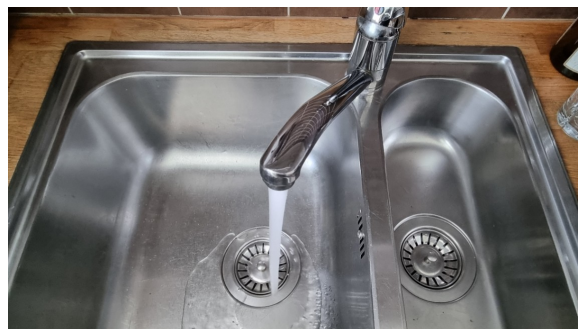
Kontroll av vanntrykk og avrenning.
