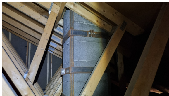
Kontroll av pipen på kaldloftet.
