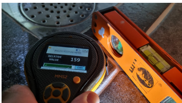
Fuktmåling og kontroll av fall mot sluk.
