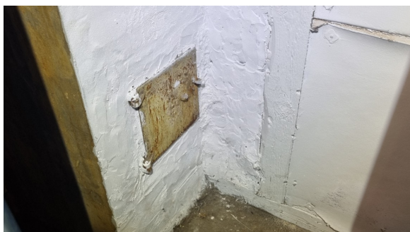
Kontroll av sotluke.
