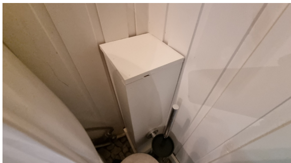
Lufting av kloakken i toalettrommet i 2. etasje.
