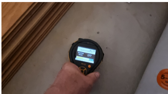
Fuktmåling i gulv i den tilbygde delen. Ingen unormale fuktverdier ble registrert.
