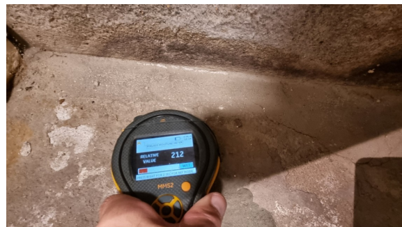
Fuktmåling av kjellergulv i fyrrom. Ingen unormale fuktverdier ble registrert.
