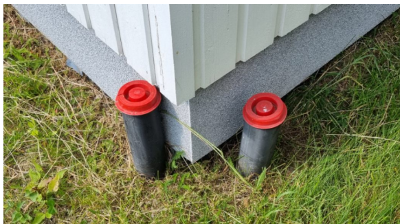
Stakepunkt på drenerør.
