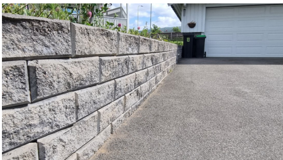
Kontroll av forstøtningsmur.
