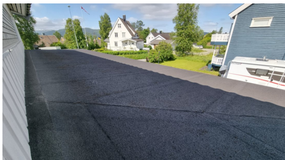
Visuell besiktelse av taket.
