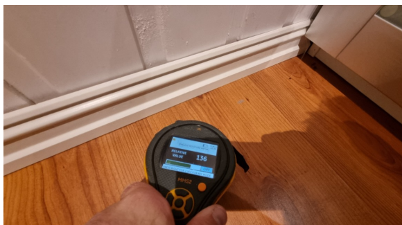
Fuktmåling på gulv/tilfarergulv i det innredede garderoberommet. Ingen unormale fuktverdier ble registrert.
