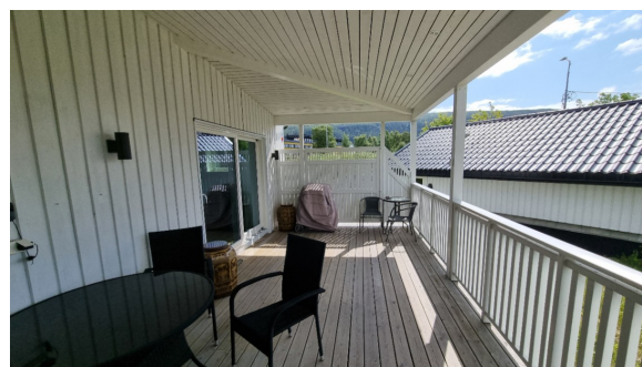
Terrassen har levegg mot sør.
