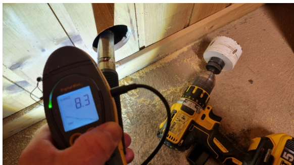
Hulltaking utført i kjelleretasjen.
