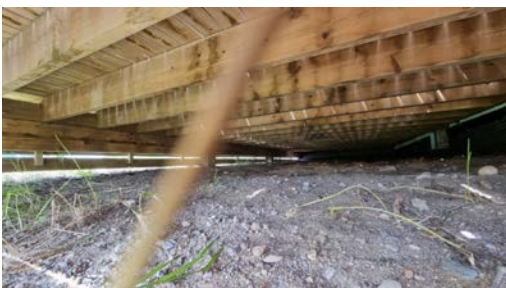
Kontroll av fundamenteringen under terrassen.
