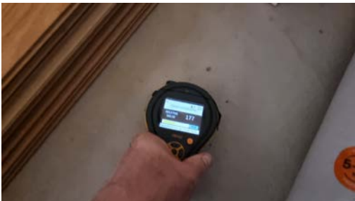
Fuktmåling i gulv i den tilbygde delen. Ingen unormale fuktverdier ble registrert.
