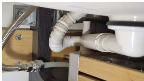
Kontroll av røropplegg under servanten.
