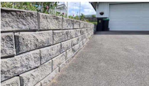
Kontroll av forstøtningsmur.
