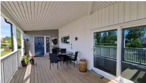
Terrassen er oppført foran inngangspartiet.
