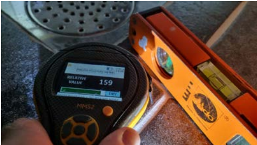
Fuktmåling og kontroll av fall mot sluk.
