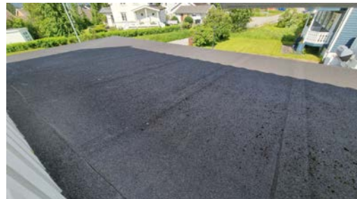
Visuell besiktelse av taket.
