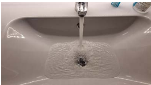
Kontroll av vanntrykk og avrenning.
