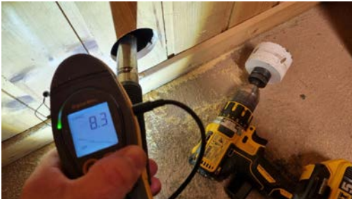
Hulltaking utført i kjelleretasjen.
