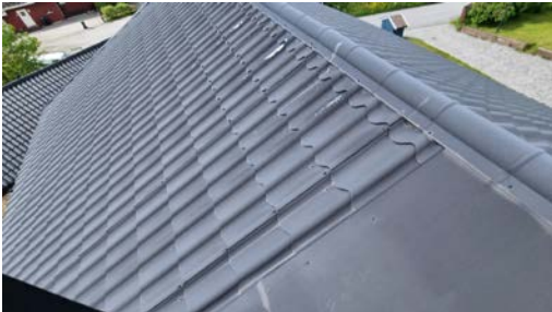
Visuell besiktelse av taket.
