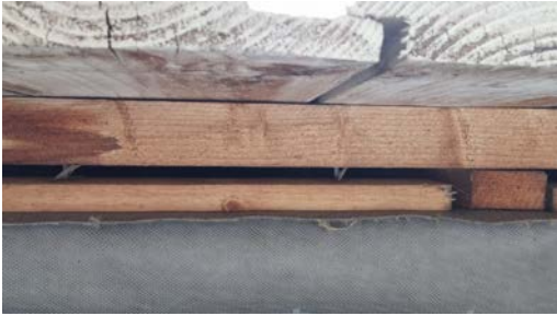
Kontroll av ytterkledningen.
