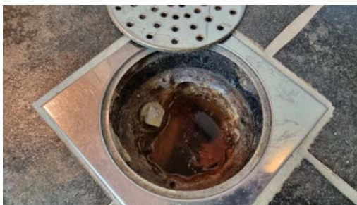
Kontroll av sluk.
