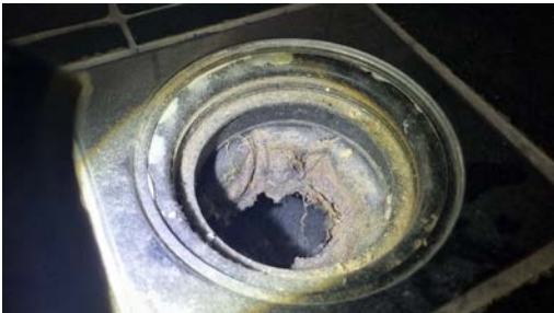
Kontroll av sluk.
