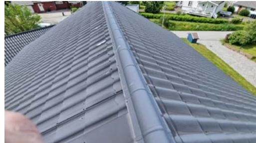
Visuell besiktelse av taket.
