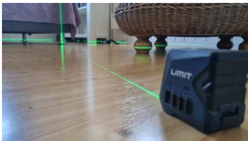
Måling av planavvik/skjevheter med krysslaser.
