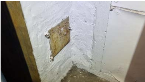
Kontroll av sotluke.
