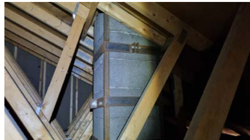
Kontroll av pipen på kaldloftet.
