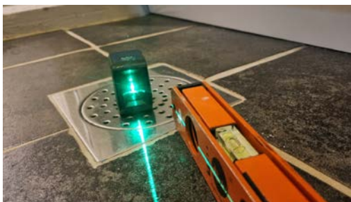
Kontroll av fall mot sluk.
