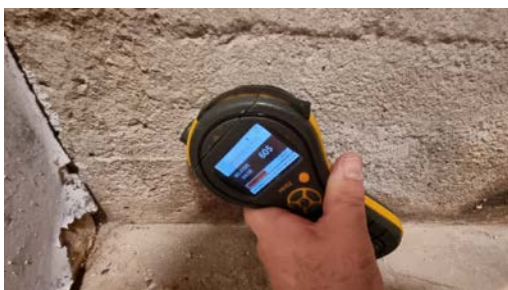
Fuktmåling i kjeller.
