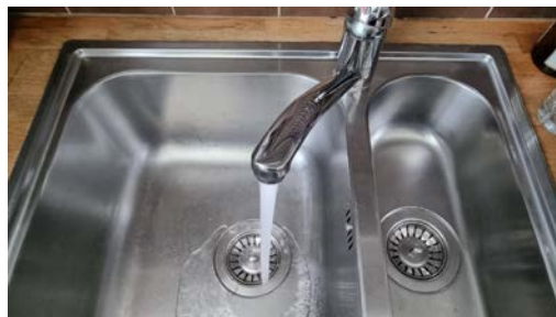
Kontroll av vanntrykk og avrenning.
