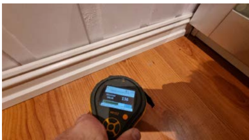
Fuktmåling på gulv/tilfarergulv i det innredede garderoberommet. Ingen unormale fuktverdier ble registrert.
