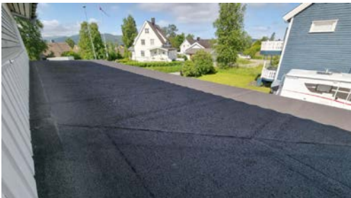
Visuell besiktelse av taket.
