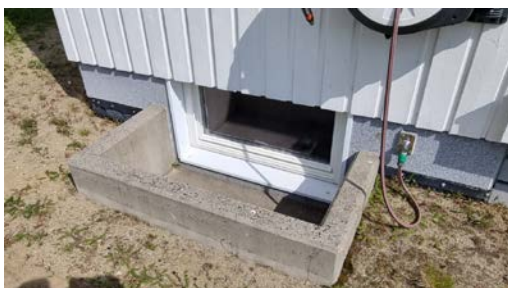
Lysgrav utenfor kjellervindu i tilbygget del.
