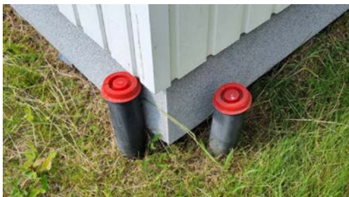
Stakepunkt på drenerør.
