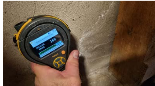
Fuktmåling direkte på betongyttervegg på flere steder. Ingen unormale fuktverdier ble registrert,
