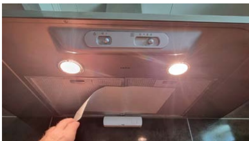
Funksjonstesting av det mekaniske avtrekket over koketoppen.
