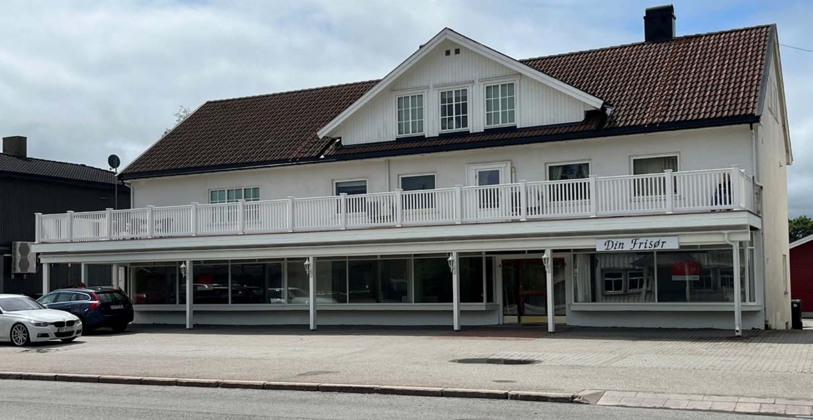
Fasaden sett fra Kaffegata. Boligen ligger i bygget's 2. og 3. etasje.
