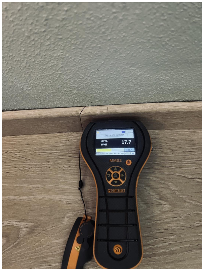
Antydning til forhøyede fuktverdier i kjeller.
