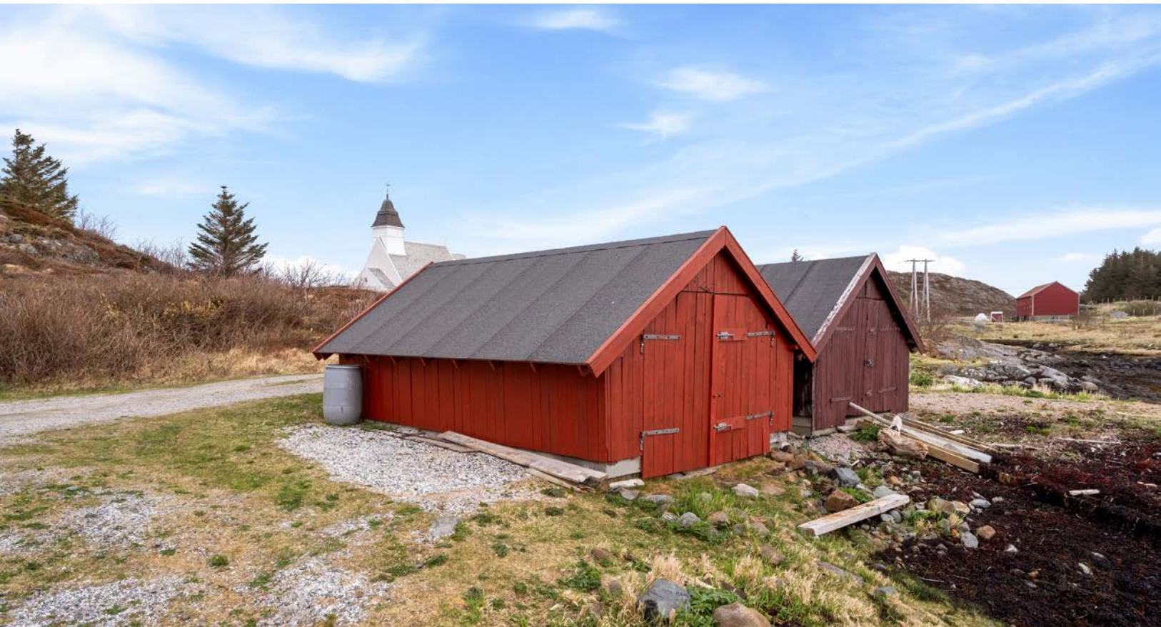
Parkeringsplass og landingsplass for båt.
