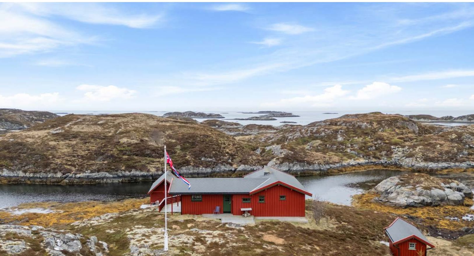
Fasade øst, med utsikt vestover.
