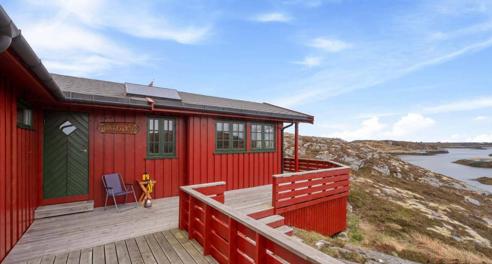
Hytta har en markterrasse med spaltetekke i tre og rekkverk, fundamentert på støpte søyler. Solcellepanel på taket.
