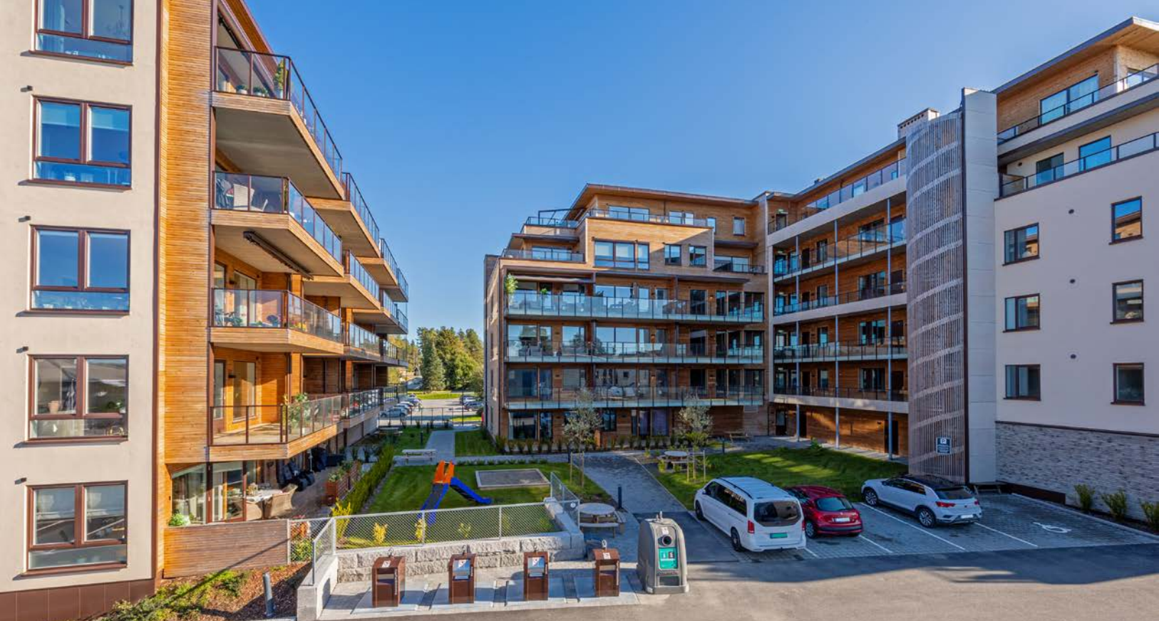
Fellesområdet er pent opparbeidet med internveier/gangveier, område for lek og opphold, grøntområder, gjesteparkering og område for renovasjon.
