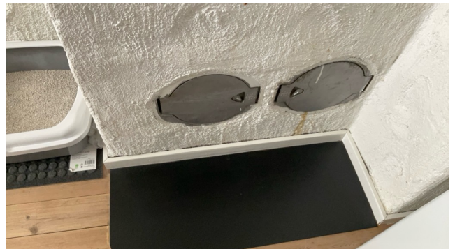
Astand feieluke til brennbart materiale er mindre enn 30 cm.
