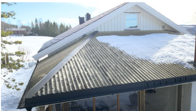
Vindu loft over tak av plastplater
