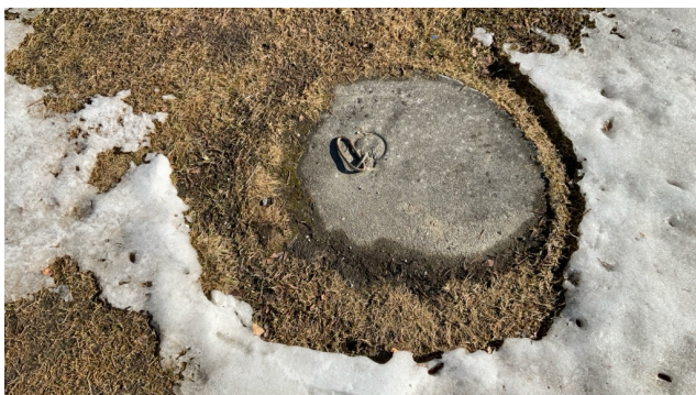
Kum for borehullsbrønn i følge eier, lokk sitter fast grunnet tele
