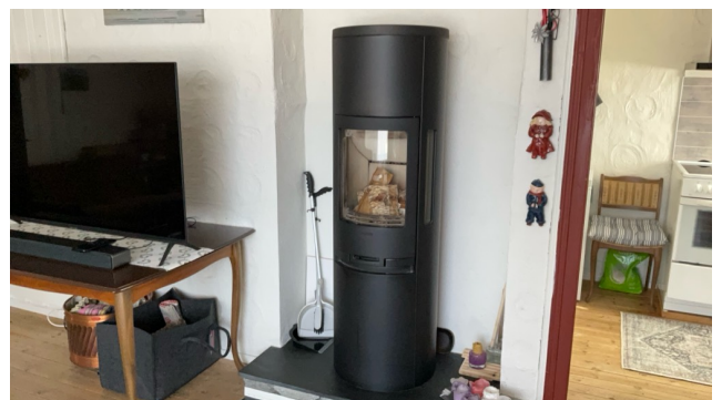
Astand feieluke til brennbart materiale er mindre enn 30 cm.
