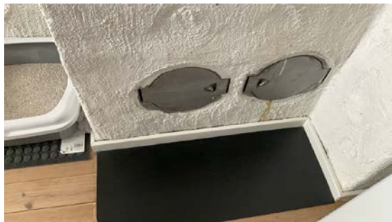
Astand feieluke til brennbart materiale er mindre enn 30 cm.
