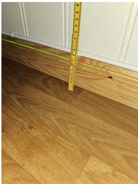
Bilde viser måling av etasjeskiller.
