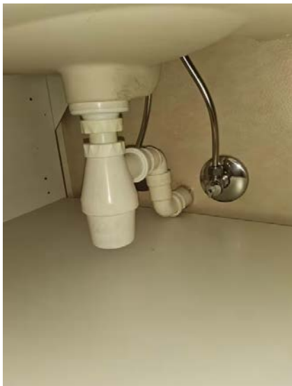
Bilde viser avløpsrør på bad.
