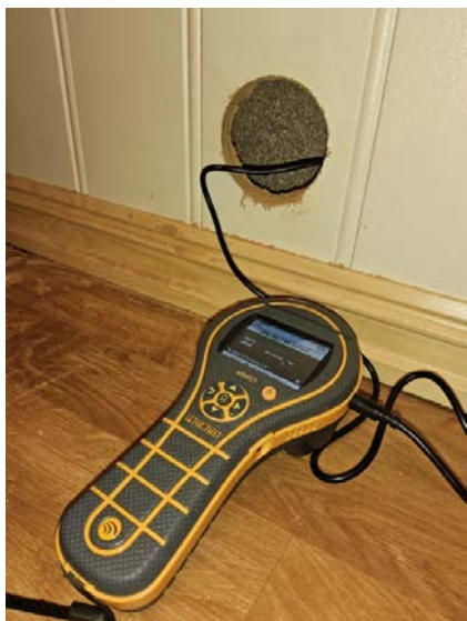
Bilde viser fuktmåling.
