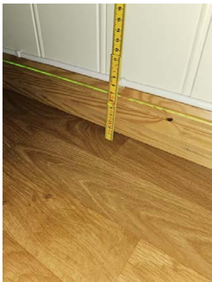
Bilde viser måling av etasjeskiller.
