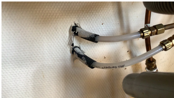
Det mangler tettemuffer i enden av varerrør i benkeskap på kjøkken.
