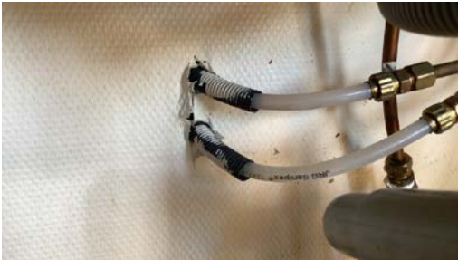
Det mangler tettemuffer i enden av varerrør i benkeskap på kjøkken.
