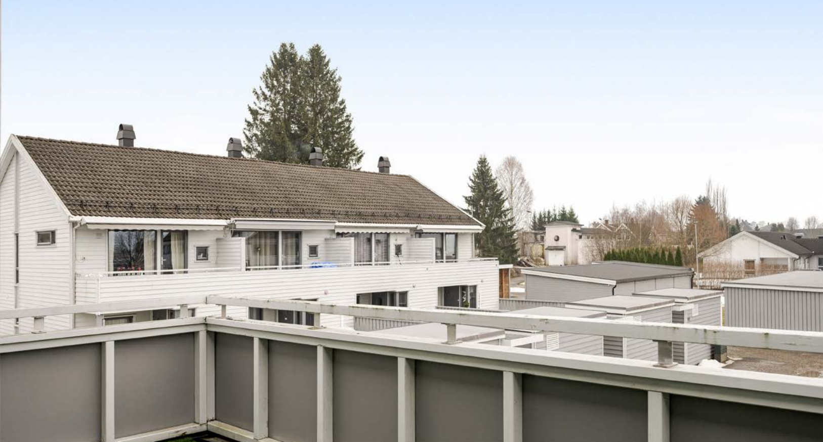
Sørvendt balkong med adkomst fra stuen. Balkongen har tett rekkverk.
