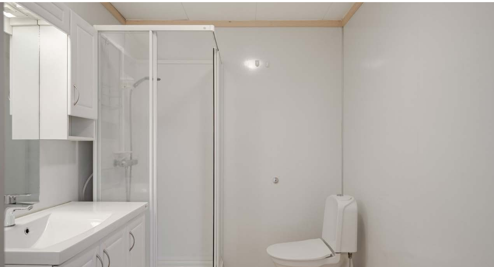
Dusjkabinett og mekanisk ventilasjon på badet.
