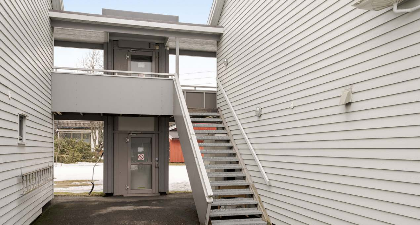
Adkomst med trapp opp til 2. etasje. Det er vareheis opp til andre etasje i svalgangen, denne er ikke lenger til bruk for personer.
