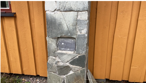
Utvendig sotluke på en pipe.
