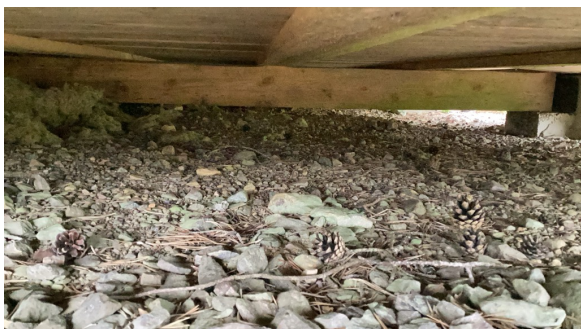
Det er åpent under bjelkelag
