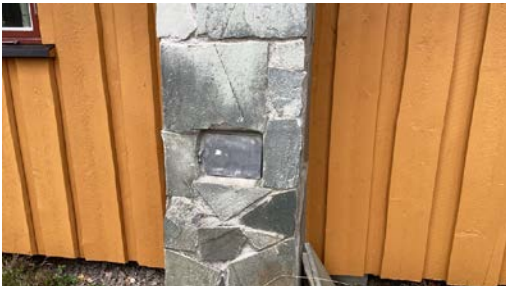
Utvendig sotluke på en pipe.
