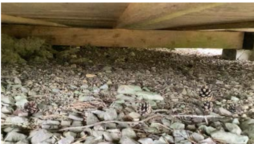
Det er åpent under bjelkelag
