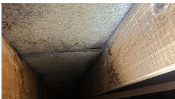
Eksempel på skadet taktro
