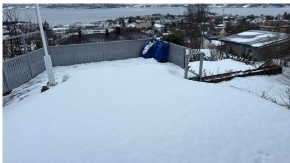
Manglende rekkverk på deler av terrassen.
