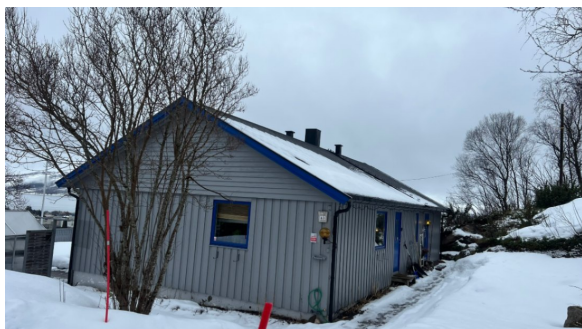
Det er krav til snøfangere på denne siden av boligens tak.
