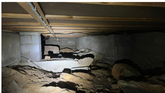
Oversiktsbilde av krypekjeller
