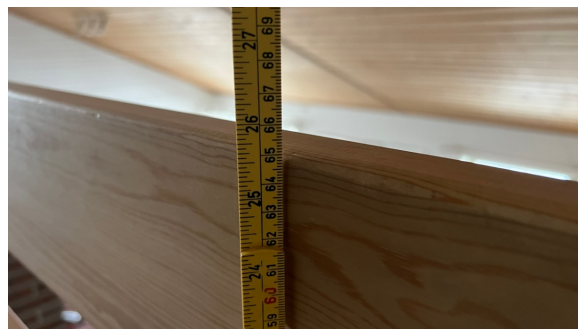
Lavt rekkverk på hemsene
