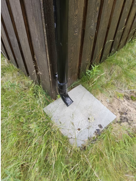
Bilde viser taknedløp avsluttet over bakken.
