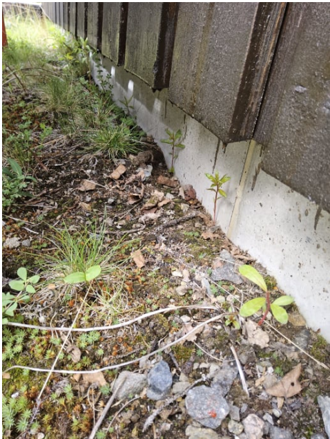
Bilde viser grunnmur.
