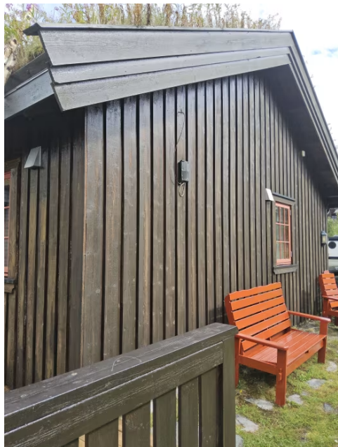
Bilde viser yttervegg.
