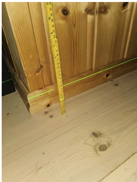
Bilde viser måling av etasjeskiller.
