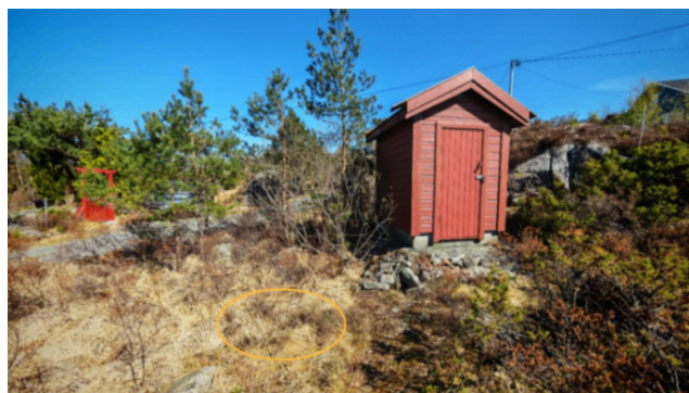
Sirkel markerer ca. hvor ventil til drenering av vann er plassert.
