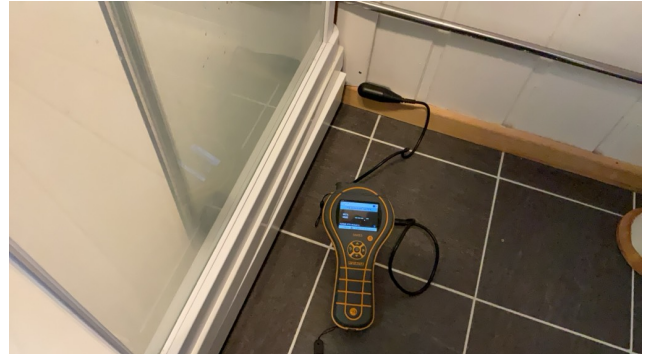
Ved fuktmåletaking av vegg ved kabinett var det ikke fuktutslag
