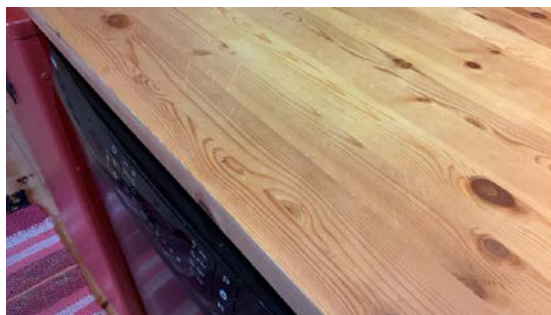
Slitasje på benkeplate
