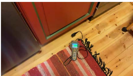
Ved fuktmåletaking av gulv foran innredning var det ikke fuktutslag
