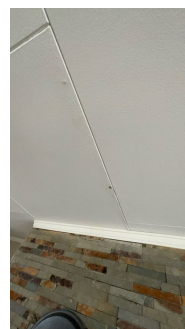
Synlige fuktmerker. Det er usikkert om fuktmerker skyldes eldre eller nyere vanngjennomtrengning.
