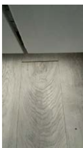
Kortskjøt på laminatgulv har sklid fra hverandre.
