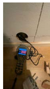
Hulltaking foretatt i bod. Fuktmåling ble foretatt, jeg målte tørre verdier i konstruksjon.
