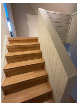
Rekkverk i øverste del av trapp, med høyde 67cm.
