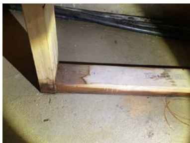
Fuktpåkjenninger på understøttelse av tre.
