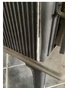
Det er utført tette-reparasjoner i hjørner.
