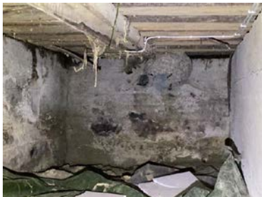
Kryperom under kjøkken.
