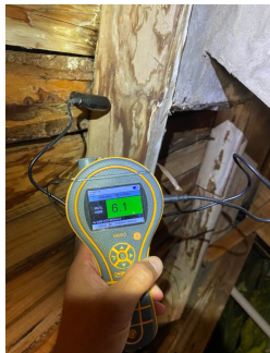
Ingen unormale verdier rundt fuktskjolder i treverk.
