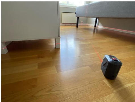
Nivellering soverom, avvik ca. 10-20 mm
