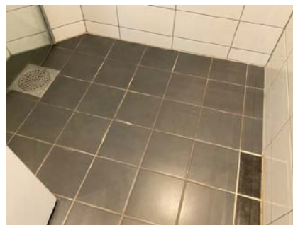
Alkalisik utslag, noe bom mm.
